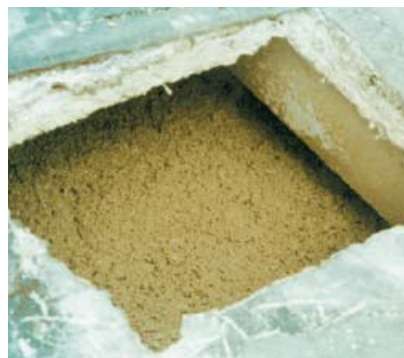
3. Otwór technologiczny do wdmuchiwania granulatów
