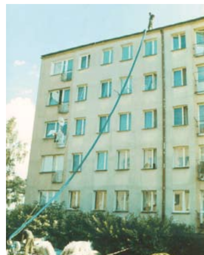
2. Ocieplenie stropodachu budynku 4-piętrowego
